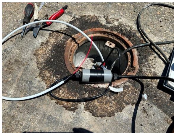
監測井水位計、氣壓計及管線安裝
