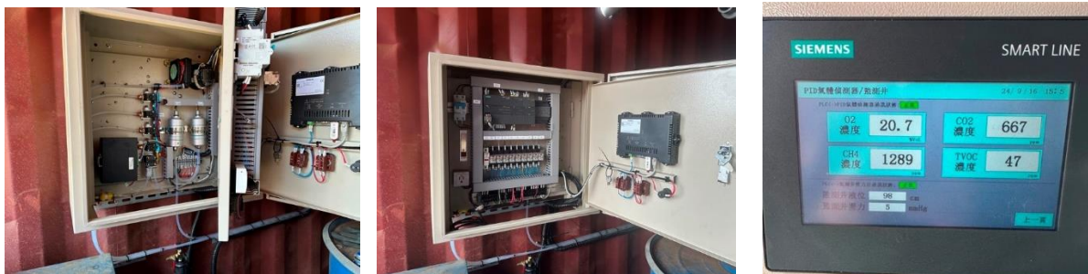
圖 4-20、PID 尾氣監測系統架構圖
