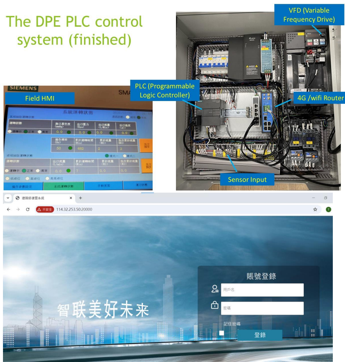
圖 4-19、已完成 SVE 遠端數據監控單元與遠端下載平台界面
