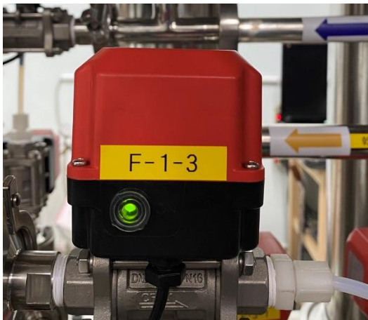
圖 十九、電動閥正常開啟之狀態(亮綠燈)
