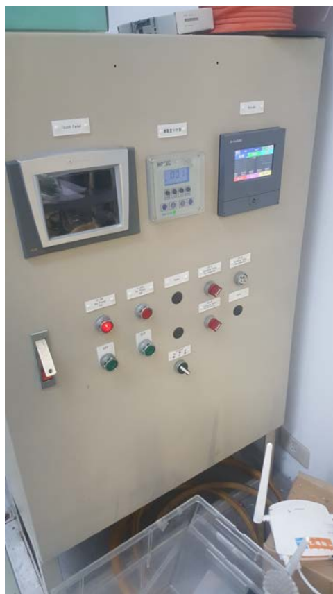
圖 59 高壓膜儀控裝置
