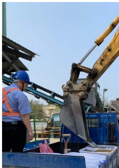
圖 5-2 低 TPH 油污染土壤採樣過程
