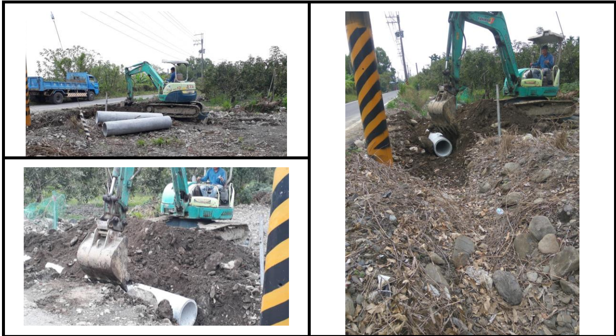
圖 7、現地模場水路涵管作業
