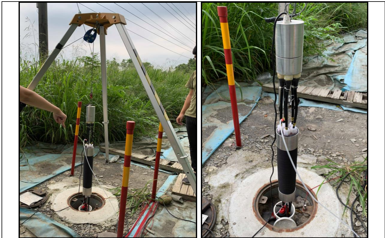
圖 38、光纖光催化系統放置處理井施工圖
