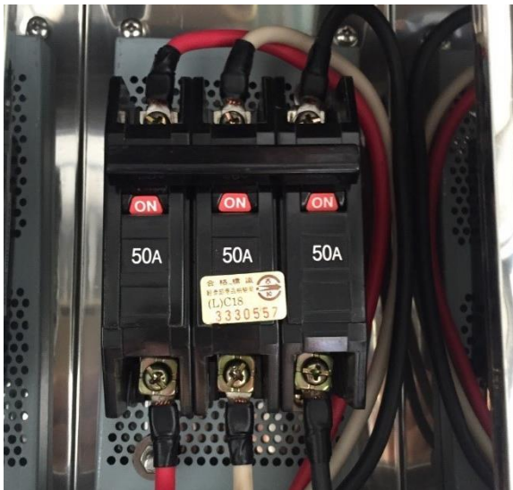
圖 41 漏電斷路器
