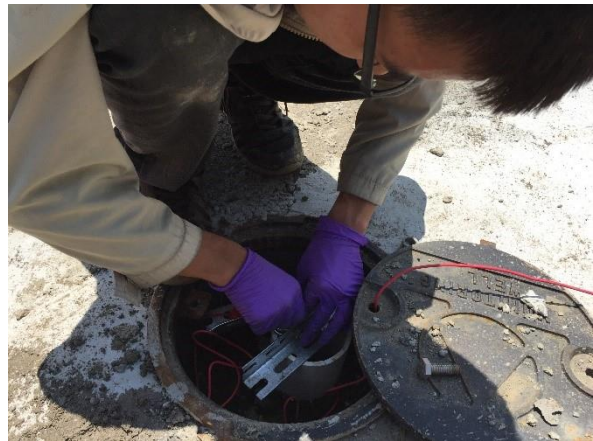
圖 56 電極井頭施作及固定
