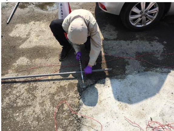
圖 53 電線保護管切割
