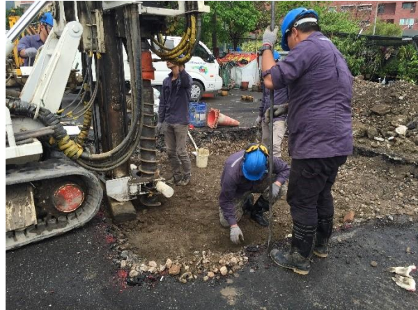
圖 46 鑿井機及人工挖掘
