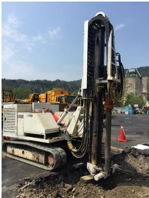
圖 47 鑿井機之作業(中空螺旋鑽)
