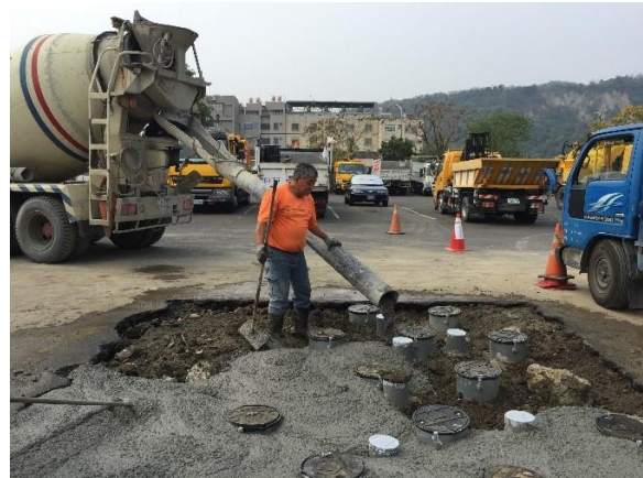
圖 50 地下水井套筒安裝
