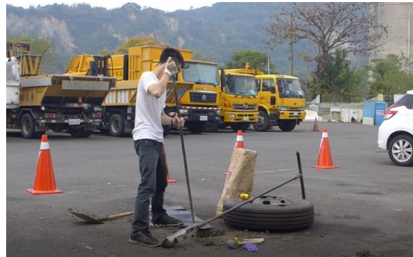
圖 40 土壤鑽探作業(土鏟)
