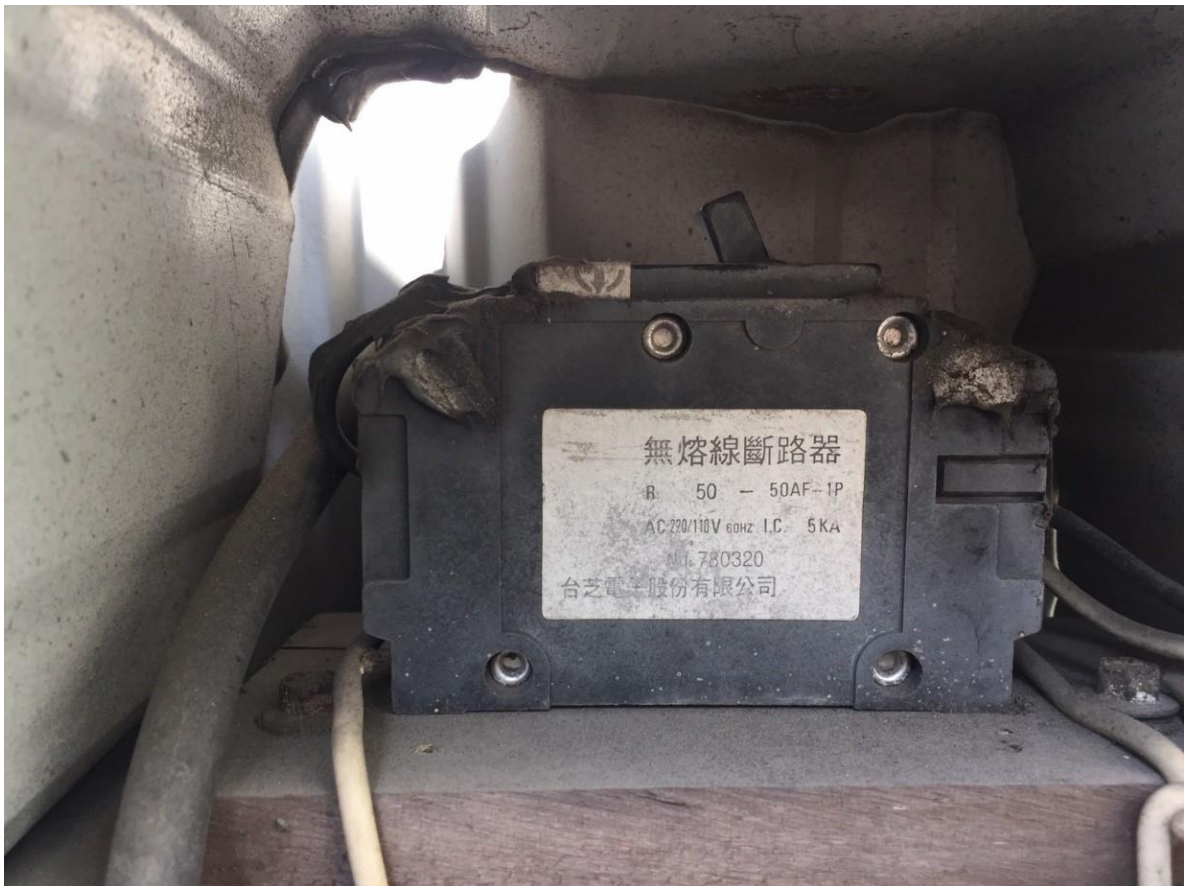
圖 29 電動力所需電源之斷路器
