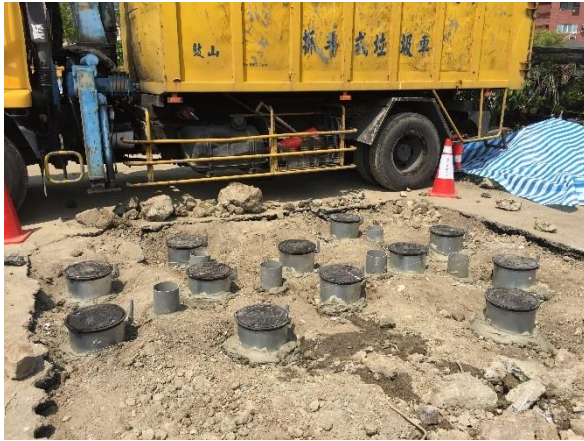
圖 49 地下水井套筒安裝
