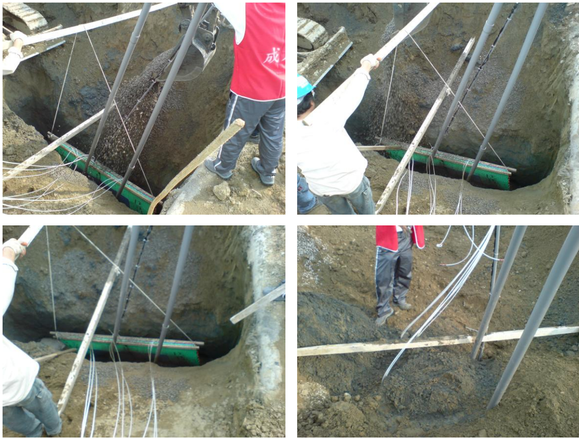
圖八 現場施工圖(一) 反應牆固定與地基回填
