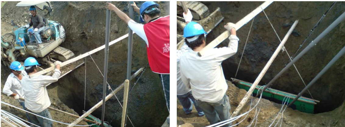
圖七 現場施工圖(一) 機械開挖與反應牆固定
