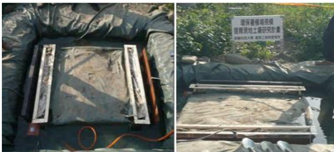
圖 1.1 電動力法(CEEK)現場不透水夾層施工圖(左)側視圖(右)
