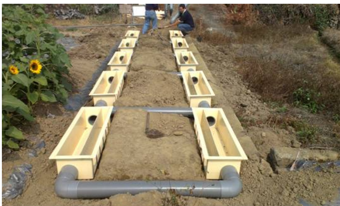
圖 2.7 電動力法(CEEK)現場施工圖(四)
