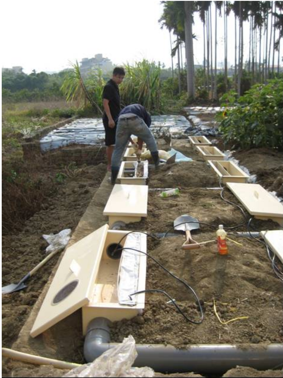
圖 2.5 電動力法(CEEK)現場施工圖(二)
