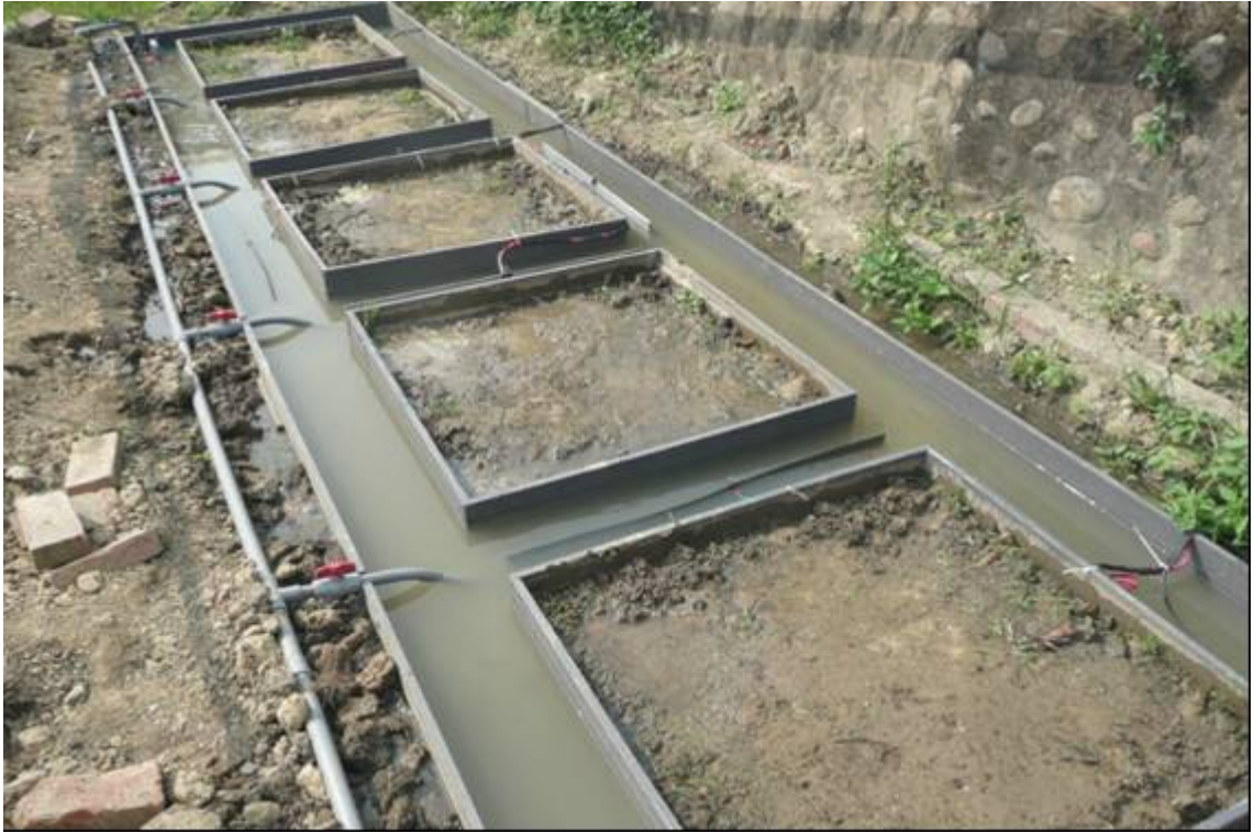
圖 1.10 電動力法(CEEK)系統裝配完成的完工情形
