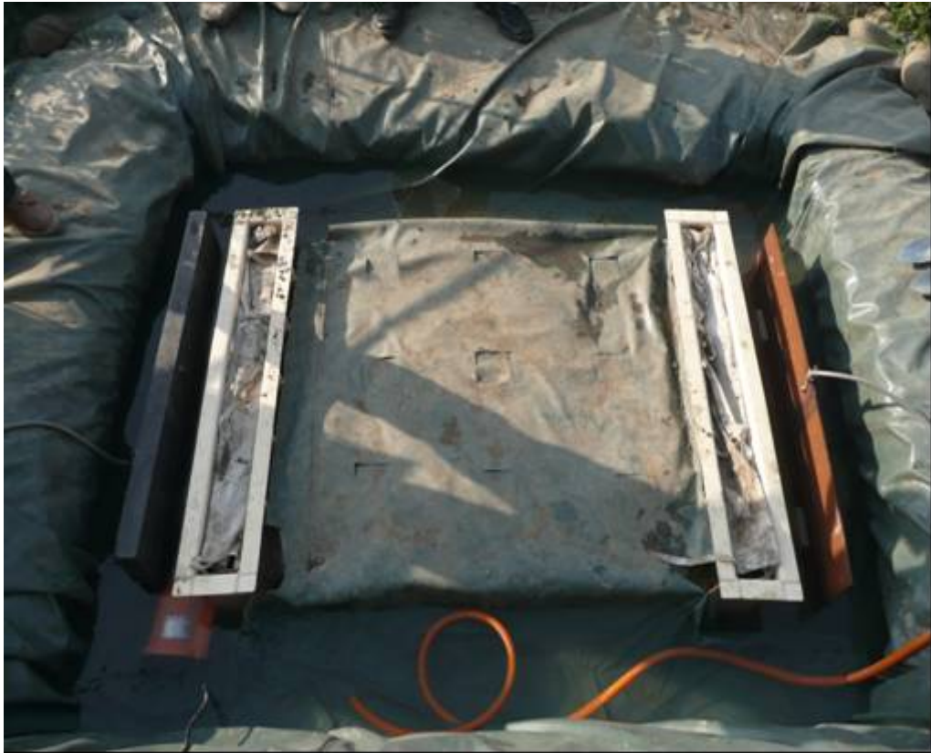
圖 1.1 電動力法(CEEK)現場不透水夾層施工圖(一)
