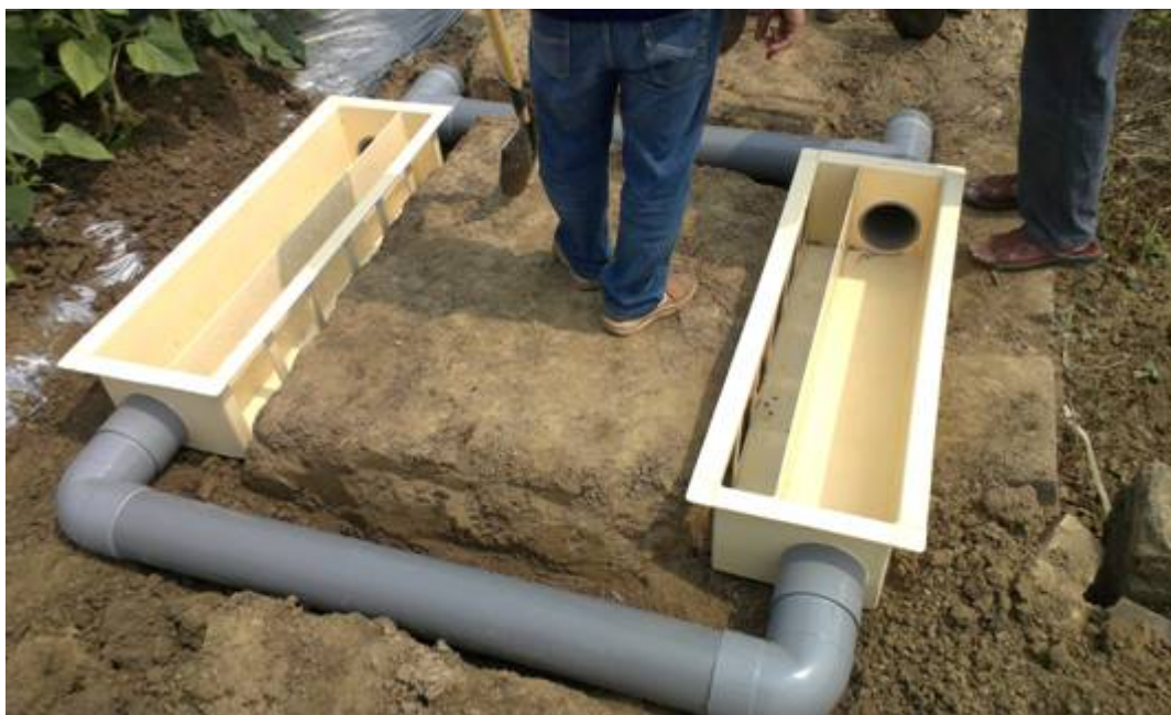
圖 2.6 電動力法(CEEK)現場施工圖(三)
