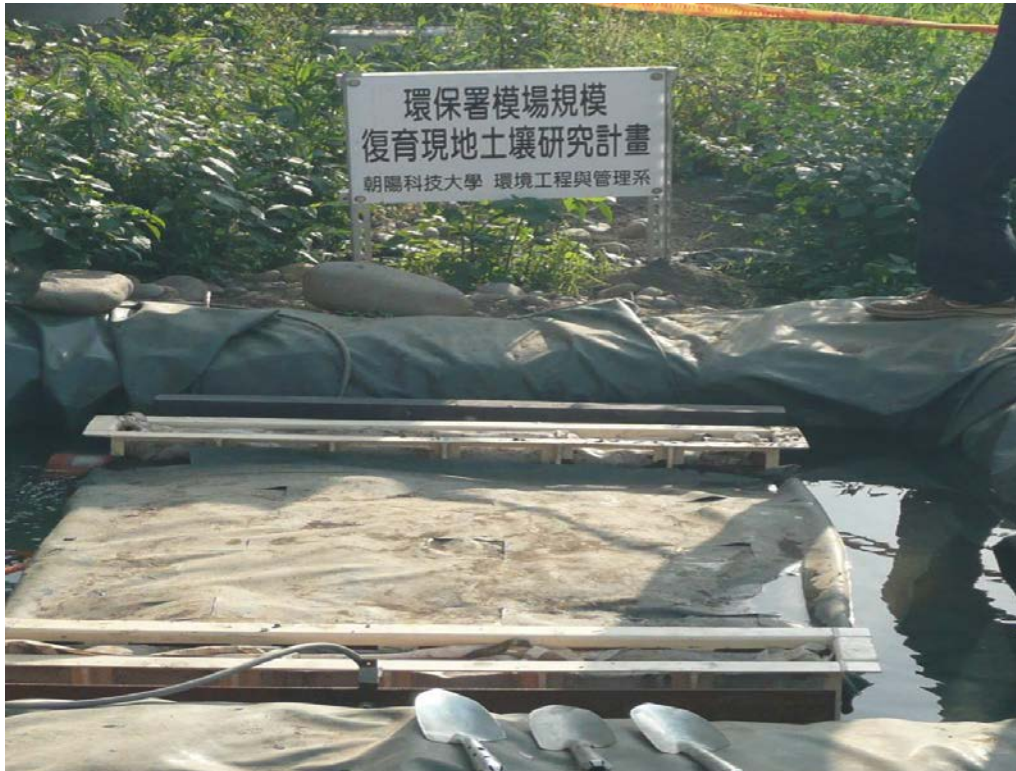
圖 1.2 電動力法(CEEK)現場不透水夾層施工圖(二)
