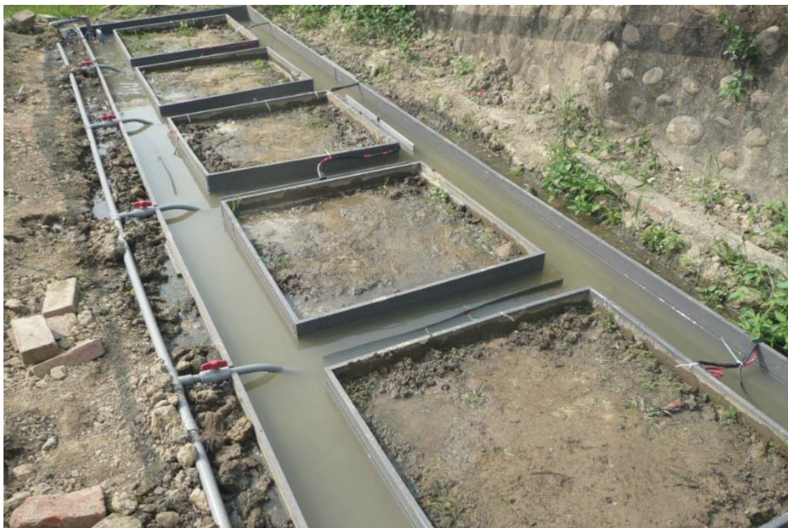
圖 2.10 電動力法(CEEK)現場施工圖(七)
