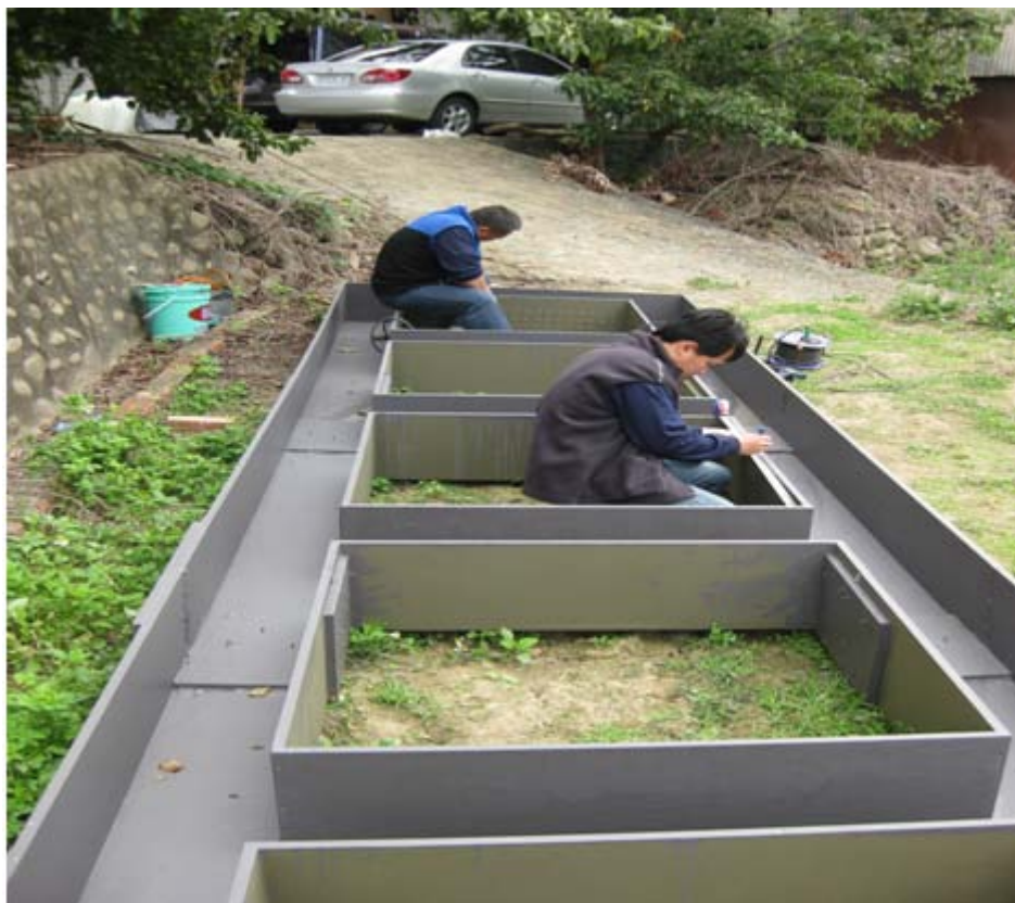
圖 2.5 電動力法(CEEK)現場施工圖(二)
