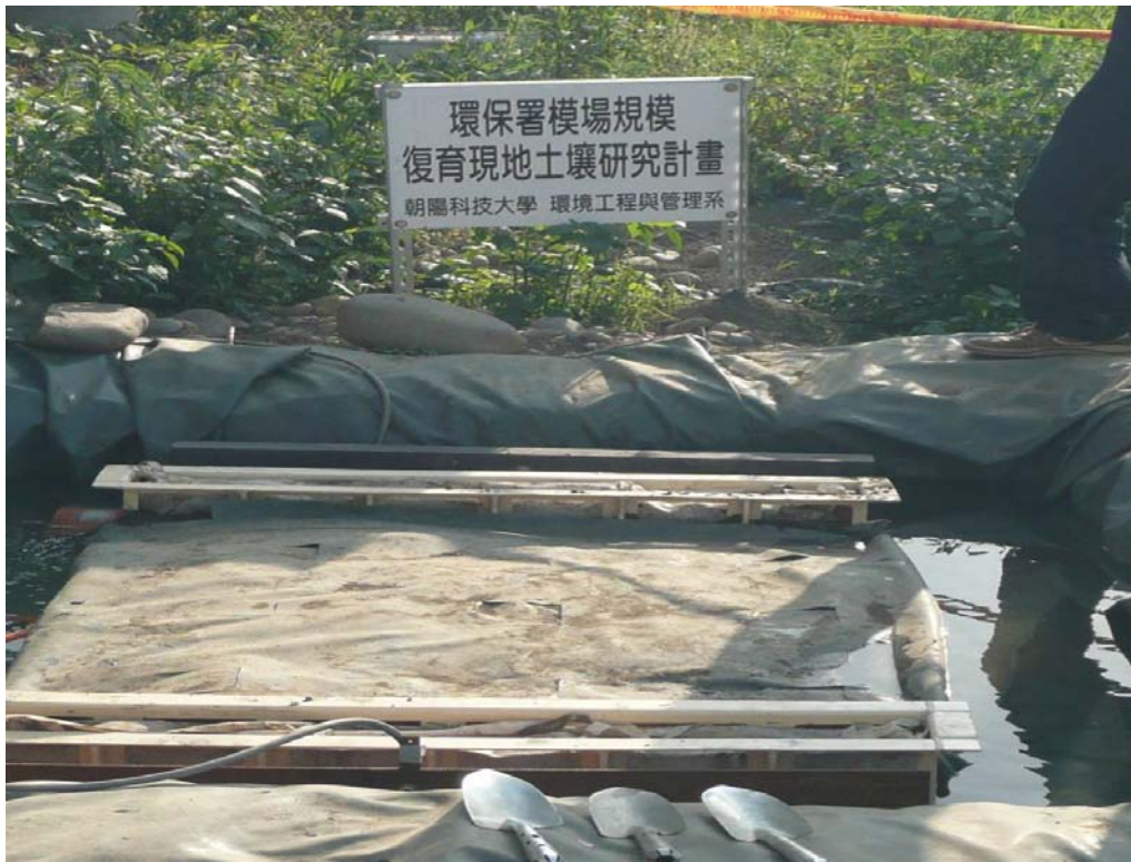
圖 1.2 電動力法(CEEK)現場不透水夾層施工圖(二)
