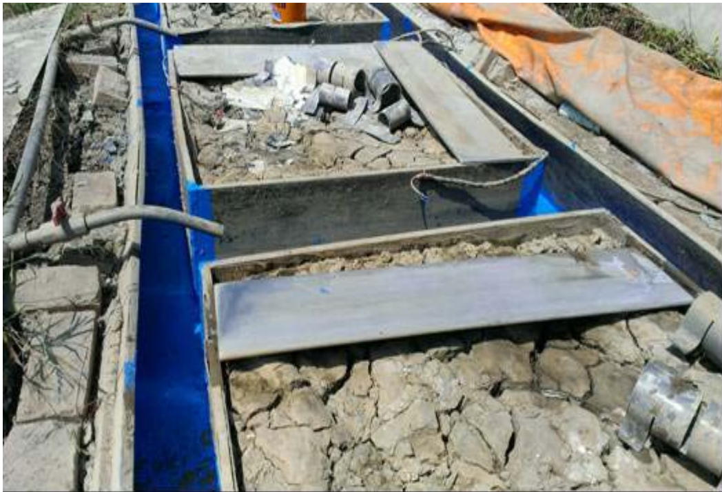
圖 3.9 蘇拉颱風後輸送渠道毀損的情形
