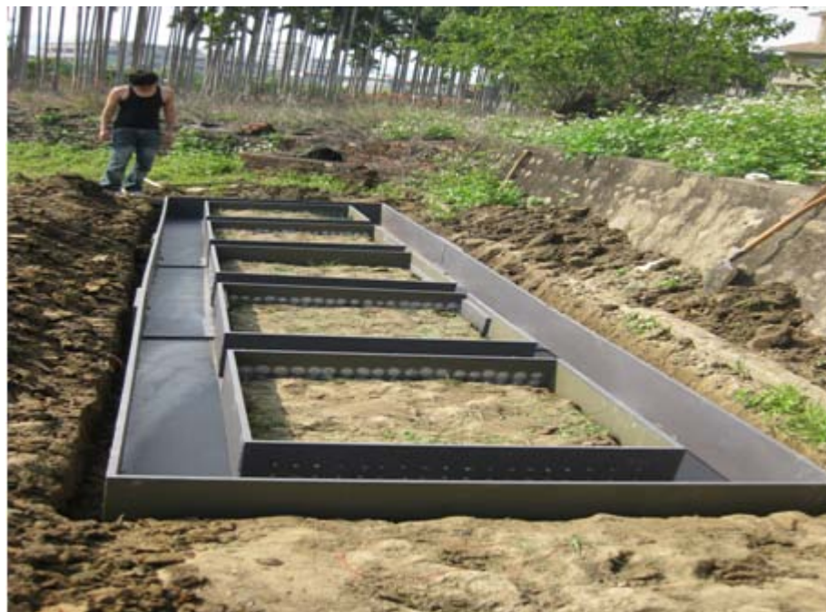
圖 2.7 電動力法(CEEK)現場施工圖(四)
