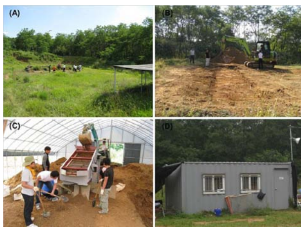
圖 16、實場整地照片；(A)原廠址；(B)整地中；(C)污染土壤過篩；(D)實場當地工寮(Lee et al.,2012)
