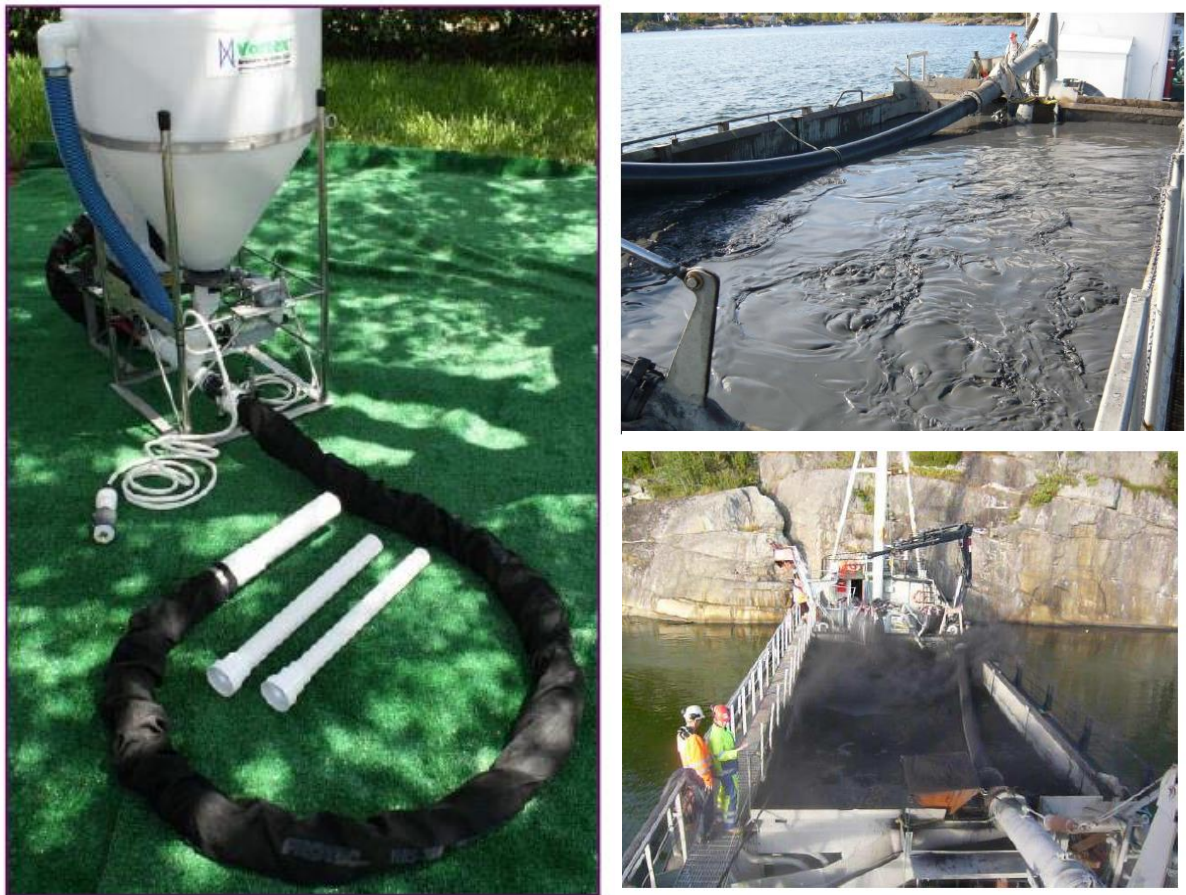
圖 3-4 噴灑式薄層覆蓋工法之施作設備。(左)Menzie et al. (2016)使用之自製噴灑裝備；(右上、右下) Cornelissen et al. (2012) 施作船隻。
